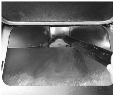
Fig. 17 - Limpeza do reservatório
